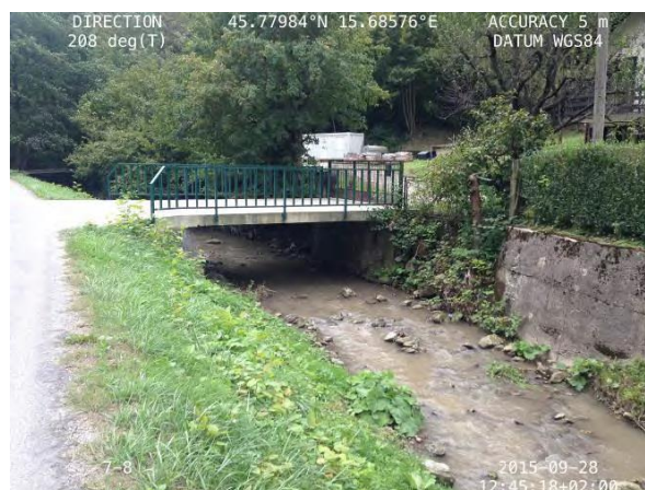
Slika 1.3-10. Most na stac 3+009,7
