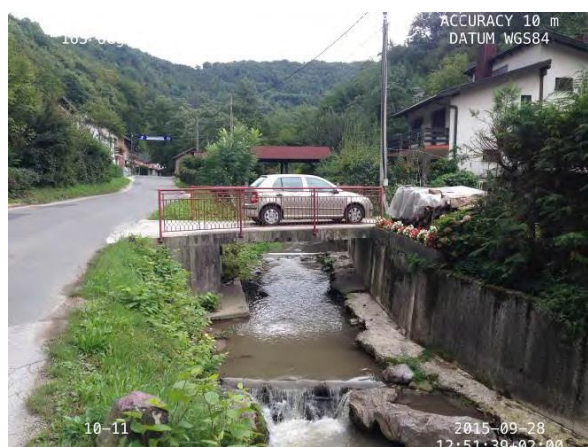
Slika 1.3-12. Most na stac 3+247,9
