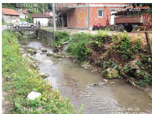
Slika 1.3-11. Most na stac 3+226,5
