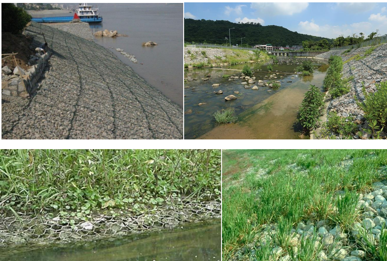
Slika 2.3.2: Ugradnja i izgled gabionskih madraca nakon izvedbe ( www.gabionwall.org n.d.)
