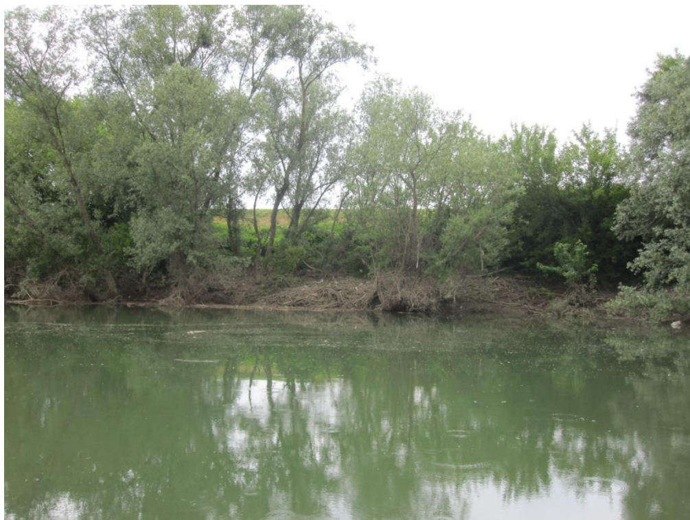
Slika 8.18: Područje planirane obaloutvrde 4 Stružec s rijekom uz nožicu nasipa
