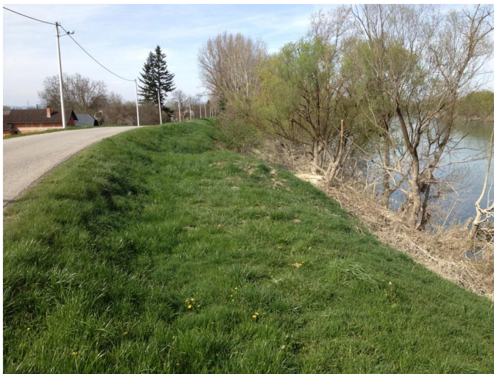
Slika 8.10: Područje planiranih obaloutvrda2 Vrbovo s kućama uz savski nasip, dok rijeka potkopava nožicu nasipa
