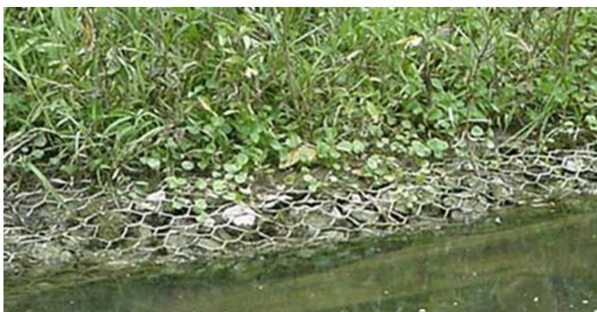
Slika 4.1.2: Prikaz obaloutvrde od gabionskih madraca
