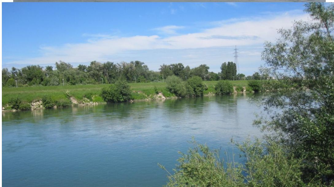
Slika 4.2.3: Korito Save s erodiranim obaloutvrdama na području Kajzerice i Jaruna
