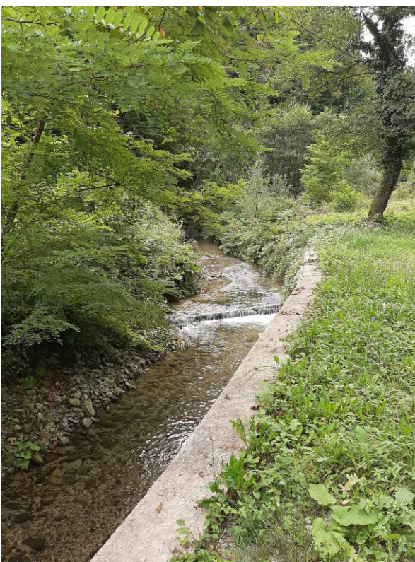
vodotok Lipovečka Gradna u stac. 4+890 postojeći hidrotehnički objekt - prag
