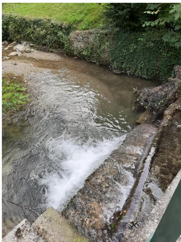
vodotok Lipovečka Gradna u stac. 5+112 postojeći hidrotehnički objekt - stepenica
