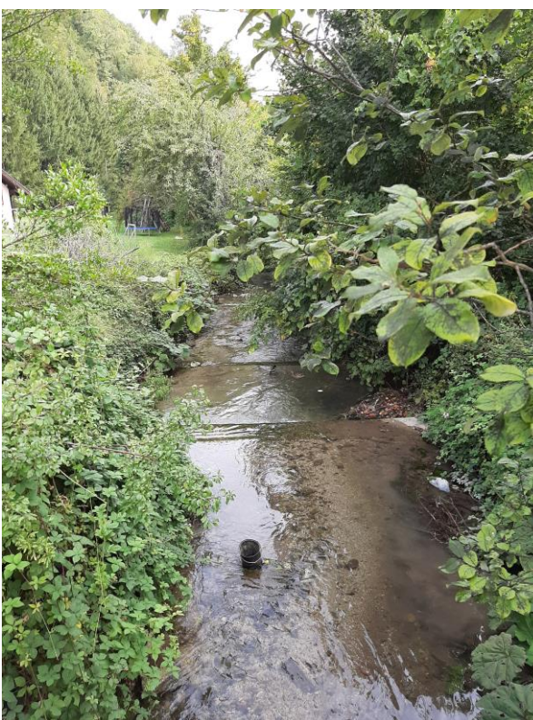
vodotok Lipovečka Gradna u stac. 5+350 postojeći hidrotehnički objekti - pragovi
