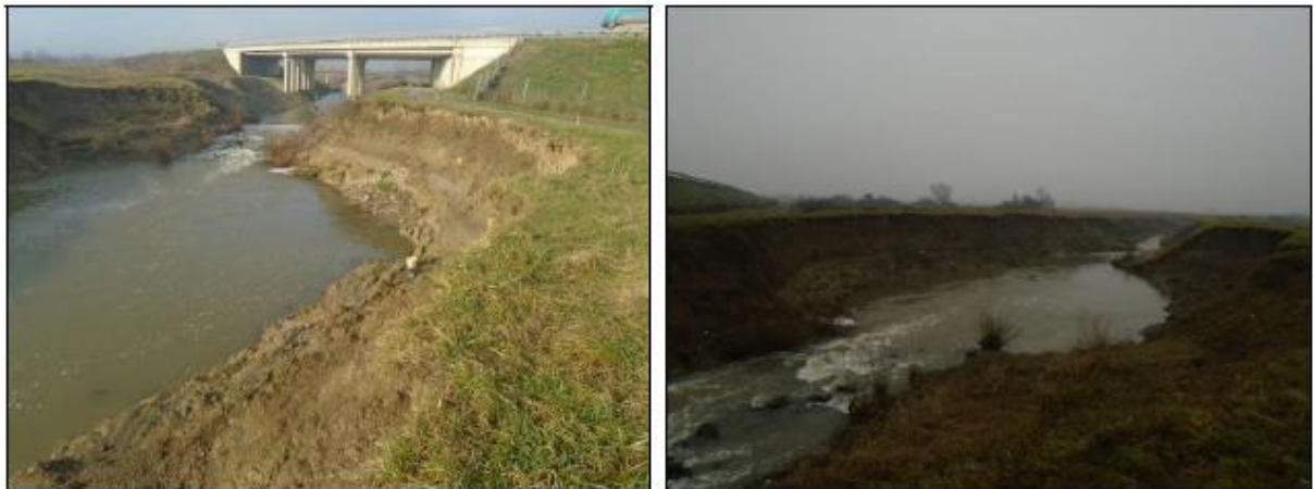
Slika 2.2.1.-2. Prirodno formirano slapište desetak metara nizvodno od betonske obloge korita
