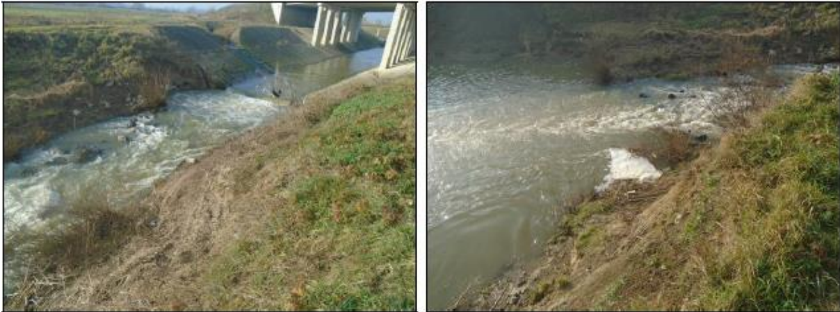
Slika 2.2.1.-1. Prirodno formirano slapište kod betonske obloge korita
