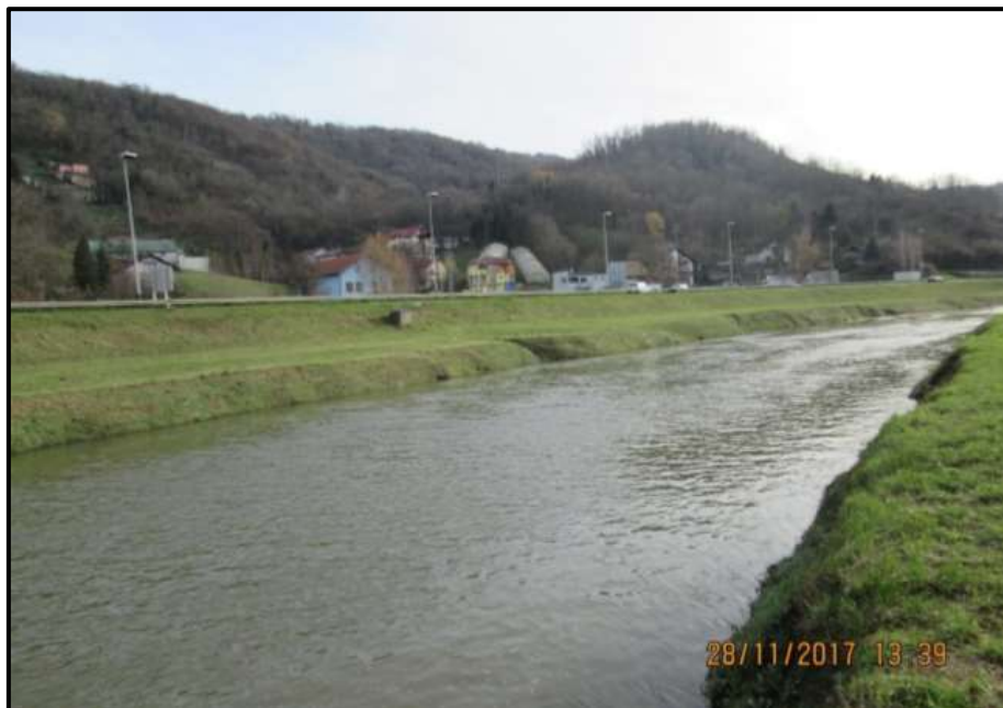
Slika 2.1-1. Okvirni izgled profila korita vodotoka Krapina na uređenom dijelu, uz početna stanja erozija na pojedinim točkastim lokacijama (izvor: VIACON, 2017.)
