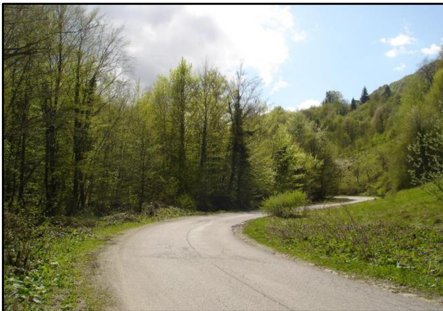
Slika 2.1-3. Pogled prema budućem retencijskom prostoru Lipovečke Gradne (preuzeto iz: Građevinski fakultet Sveučilišta u Zagrebu, 2018. )
