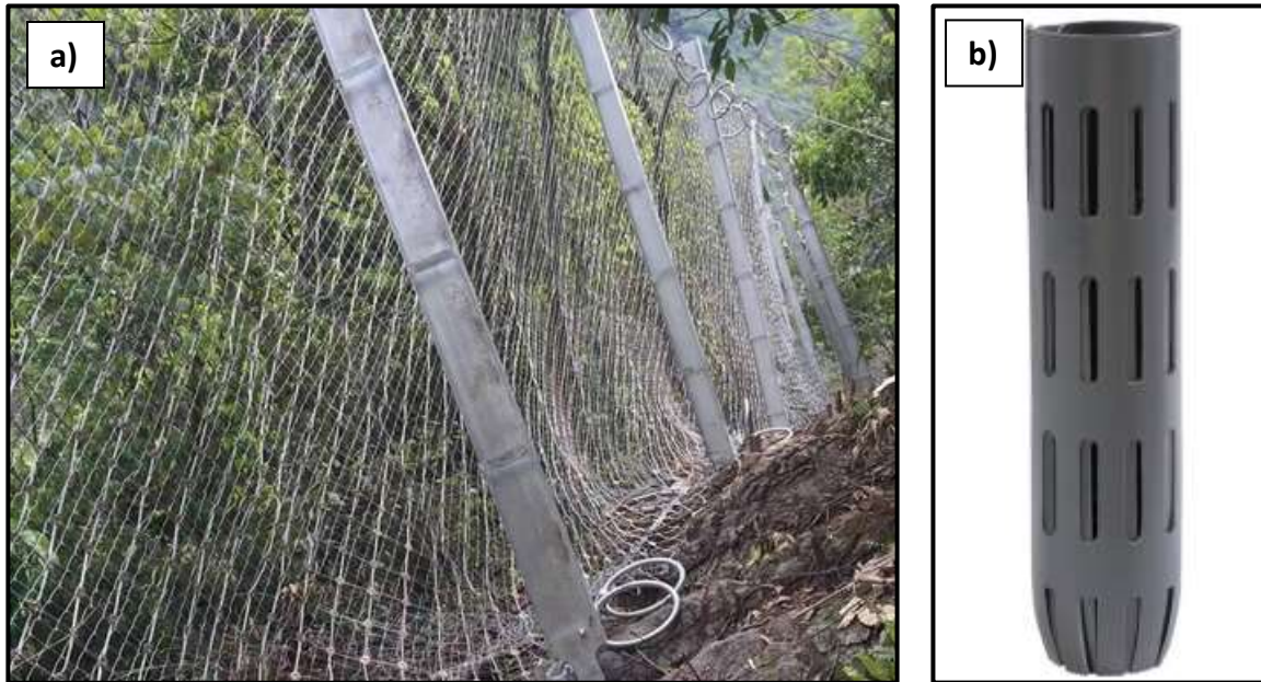
Slika 4.5-3. Primjeri mogućnosti zaštite rubnih stabala rezervata šumske vegetacije tehničkim mjerama od odrona kamenja: (a) postavljanjem mreže za hvatanje odronjenog kamenja ili (b) postavljanjem štitnika na pojedinačna stabla u pojasu rezervata uz gradilište
