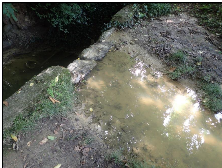
Slika 2.1-4. Postojeća betonska stepenica u stac. km 0+263,00 (izvor: Viacon, 2019. )
