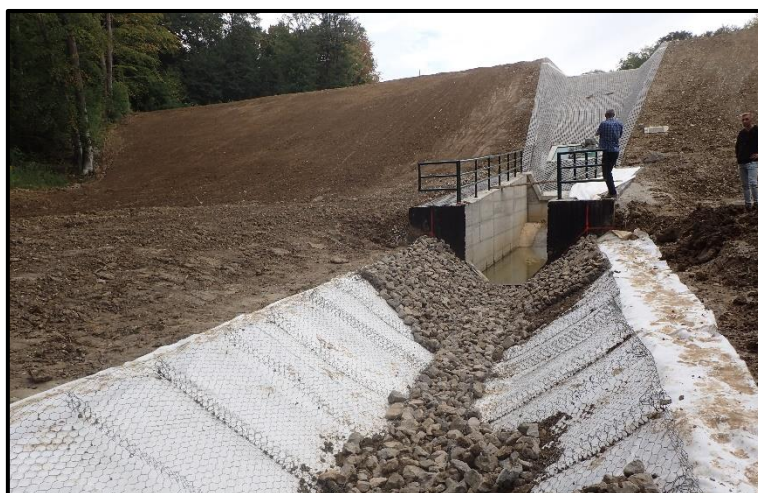
Slika 2.1-7. Kraj odvodnog kanala iz retencije, priključak na predmetnu trasu u stac. km 0+797,51 (izvor: Viacon, 2019. )
