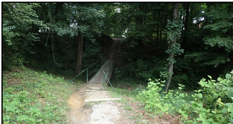
Slika 2.1-3. Postojeći pješački most u stac. km 0+095,00 (izvor: Viacon, 2019. )
