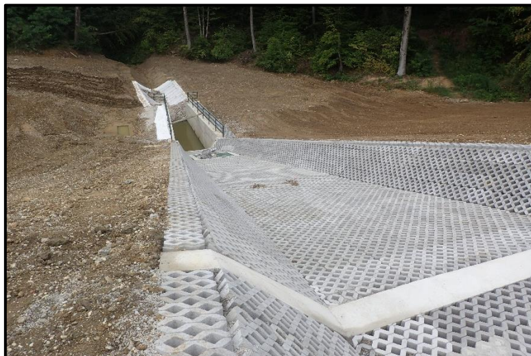
Slika 2.1-6. Postojeća betonska stepenica u stac. km 0+263,00 (izvor: Viacon, 2019. )
