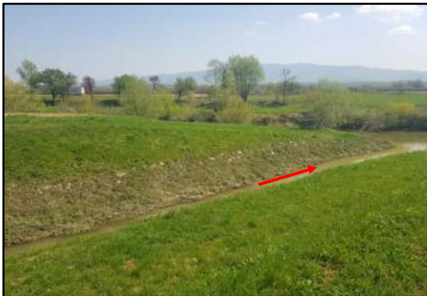
Slika 2.1-4. Postojeća kamena obloga na lijevom pokosu korita, prije samog ušća u rijeku Krapinu, s označenim smjerom tečenja (izvor: Viacon, 2019. )
