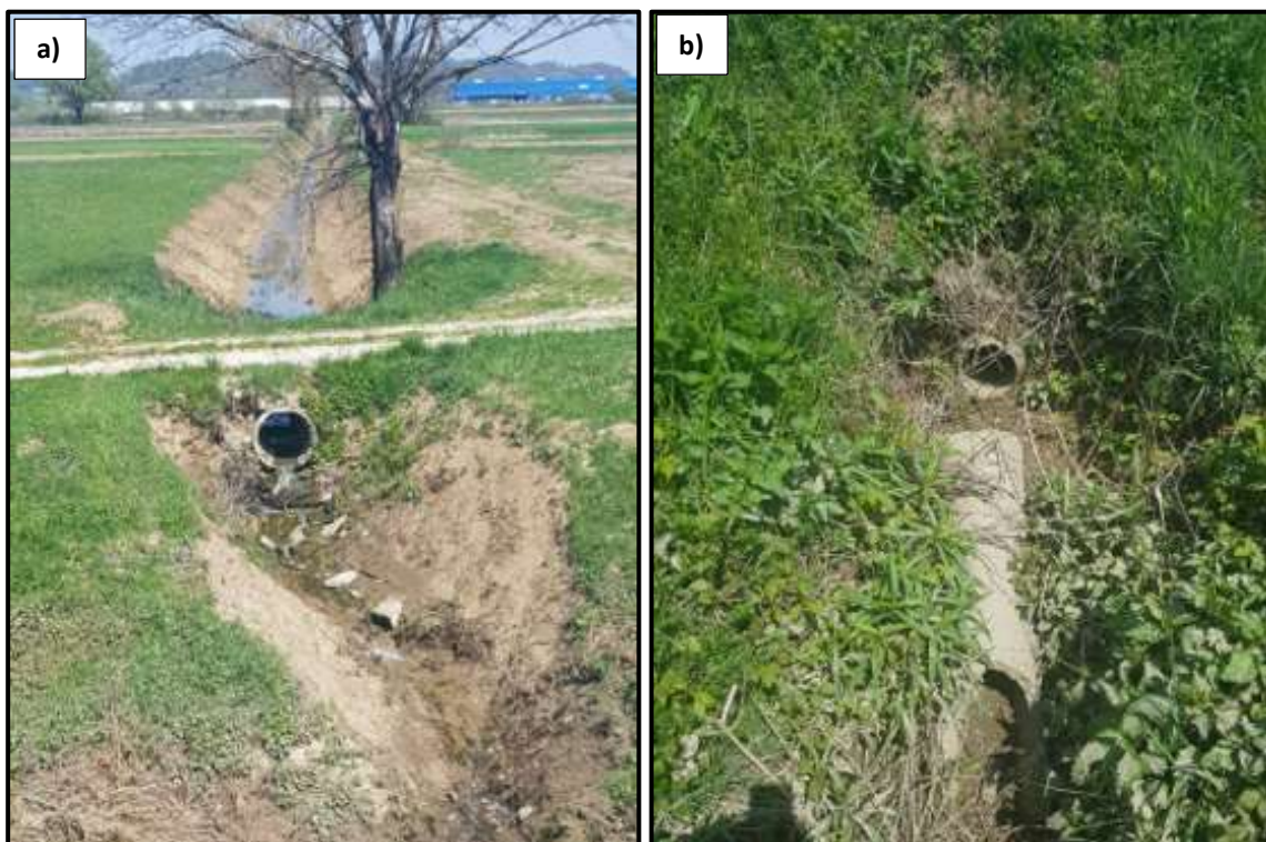
Slika 2.1-5. Ispusti melioracijskih kanala s lijeve strane korita (izvor: Viacon, 2019. )
