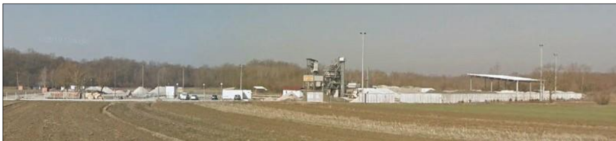
Slika 1. Pogled na asfaltnu bazu Gradec
