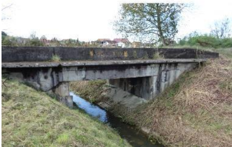
Slika 1-9: Željeznički propust u postojećem stanju
