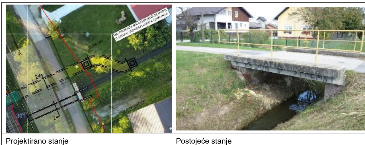
Slika 1-10: Postojeće i projektirano stanje cestovnog propusta
