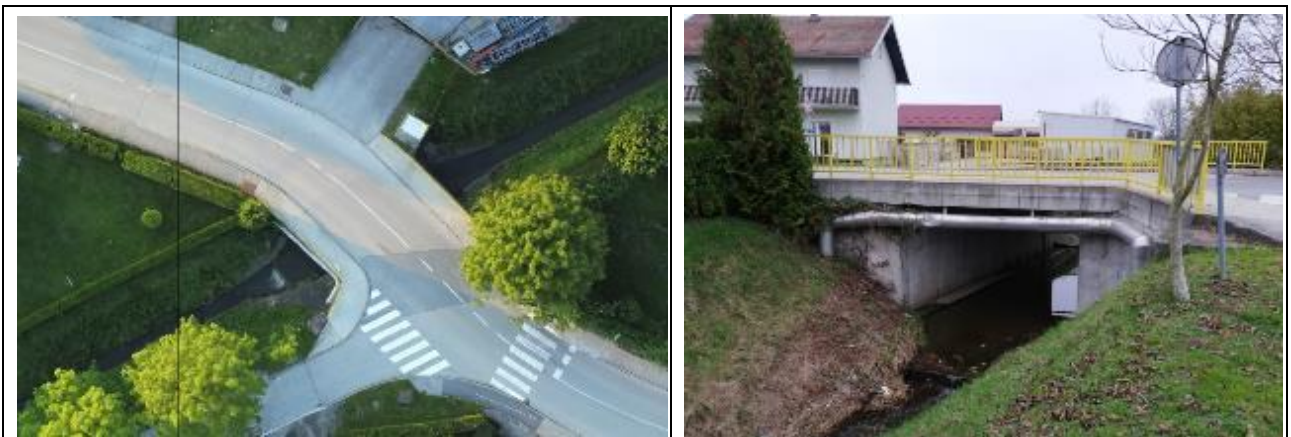
Slika 1-7: Propust na stac. Vodotoka 0+333
