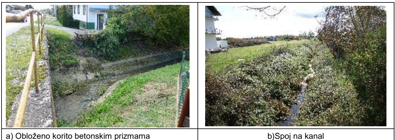
Slika 1-5: Prikaz obloženog korita Žeravinca i spojnog kanala za prevođene vode
