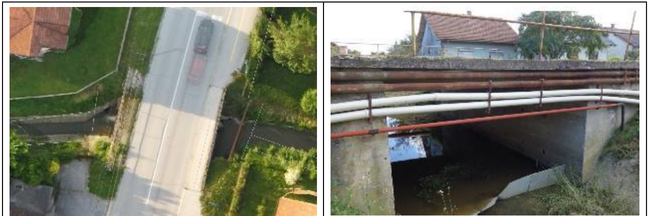
Slika 1-15: Postojeće stanje propusta ispod županijske ceste ŽC3041 u stacionaži vodotoka 1+257
