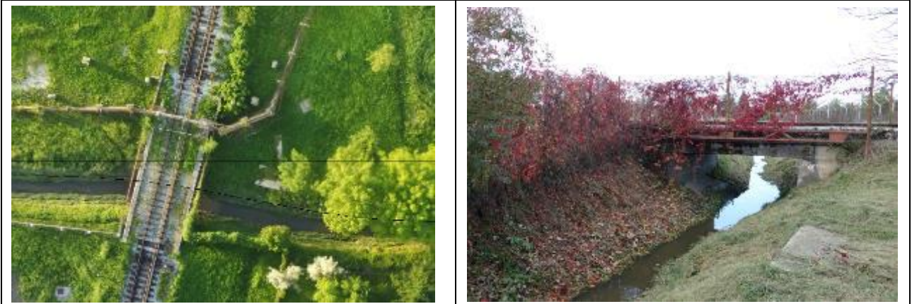
Slika 1-14: Postojeće stanje propusta ispod željezničke pruge u stac. 1+014
