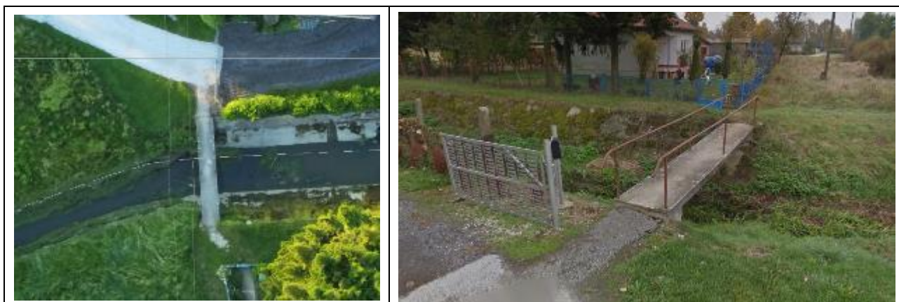
Slika 1-13: Postojeće stanje pješačkog mosta
